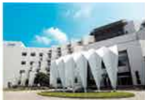
台南研發中心 (鑽石級綠建築)
